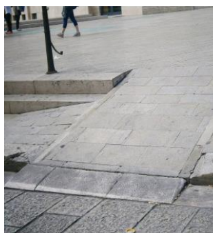
Rampa lato destro
