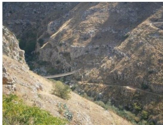
Ponte sospeso sul torrente Gravina
